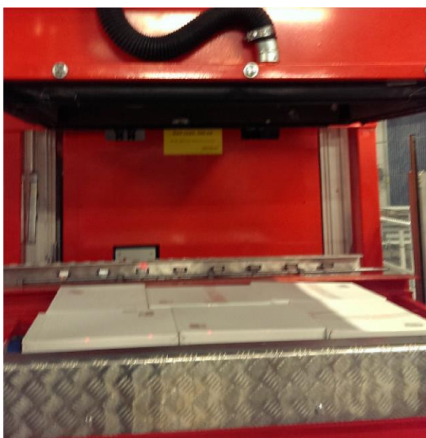
Depalleteringsmaskin i automatanlegg, klar til å løfte av et lag med varer
